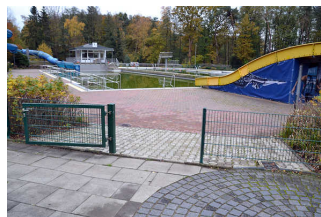
Toegangsweg buitenterrein naar het zwembassin
