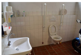
Sanitaire ruimte buitenbad - kleedcabine
