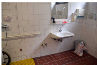
Sanitaire ruimte buitenbad - kleedcabine
