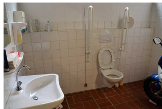
Sanitärraum in Freibad- Umkleidekabine
