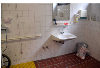
Sanitärraum in Freibad- Umkleidekabine
