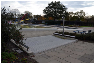
Durchschreitebecken zu den Schwimmbereichen (Alte Bauart)
