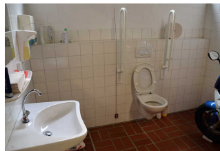
Sanitärraum in Freibad- Umkleidekabine
