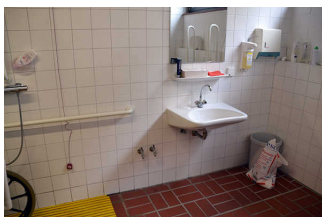
Sanitärraum in Freibad- Umkleidekabine
